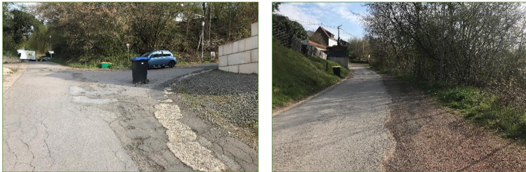
Abbildung 3 und 4: Straßenraum der Straße „Am Freidelbrunnen“ (ARGUS CONCEPT)
